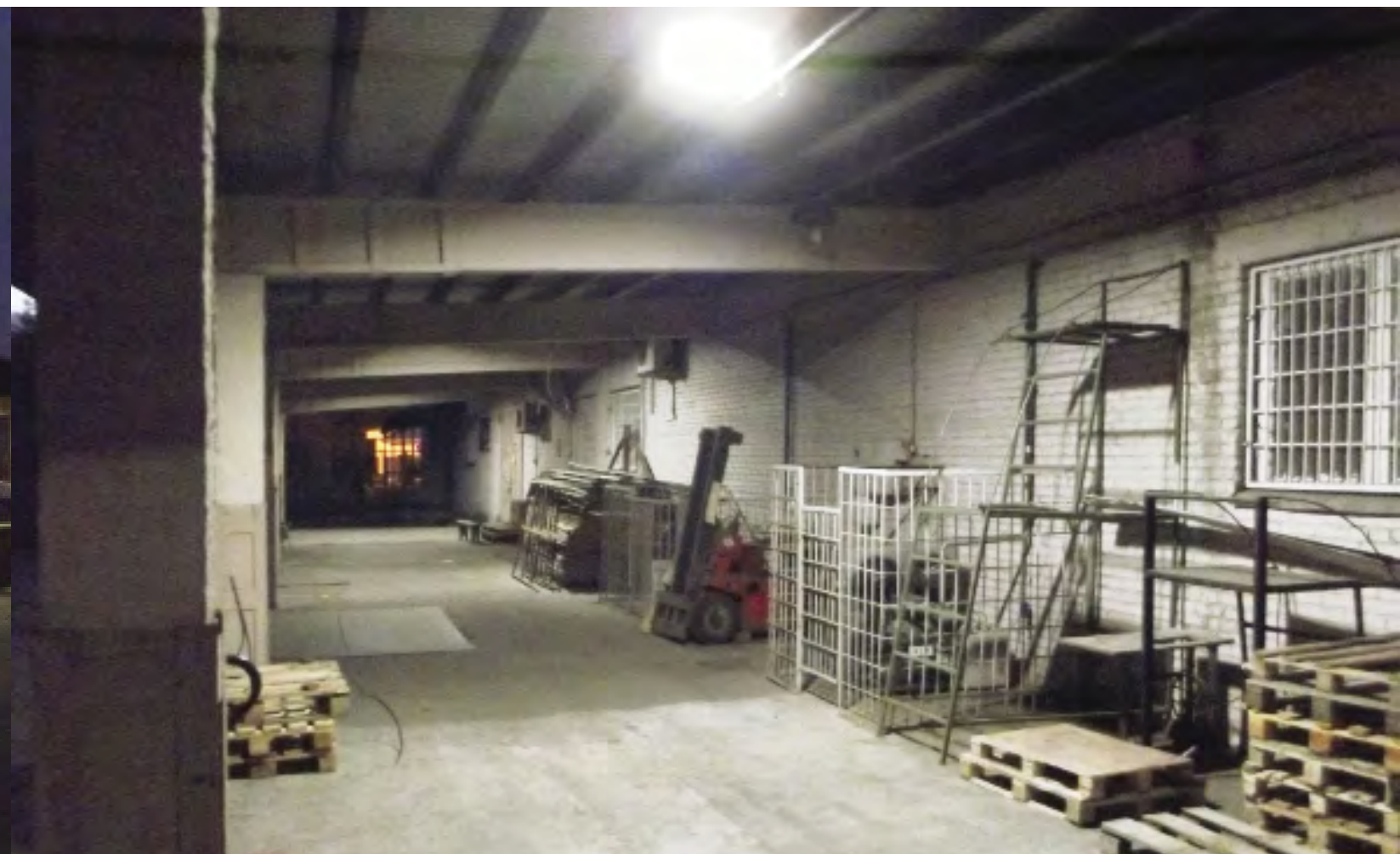
Освещение светильниками серии TUNNEL
