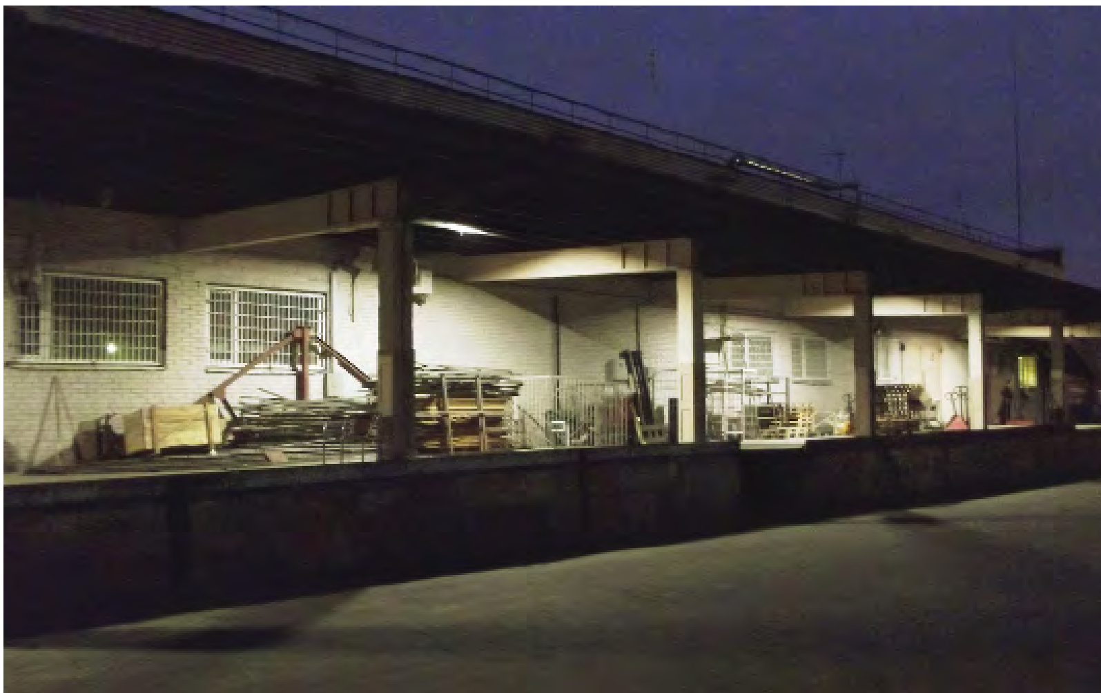
Освещение светильниками серии TUNNEL
